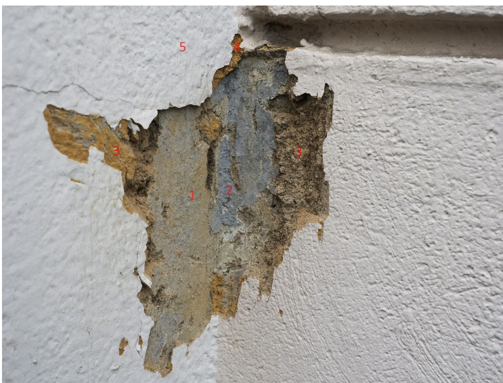
Plocha fasády s okenní špaletou. 1- štuk, 2- šedý nátěr, 3-4 – dvě okrové vrstvy, 5 - stávající barevnost
