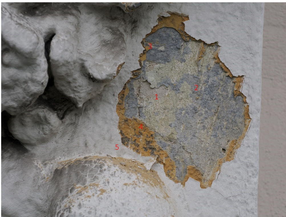
Zdobné prvky na nice. 1- štuk, 2- šedý nátěr, 3-4 – dvě okrové vrstvy, 5 - stávající barevnost
