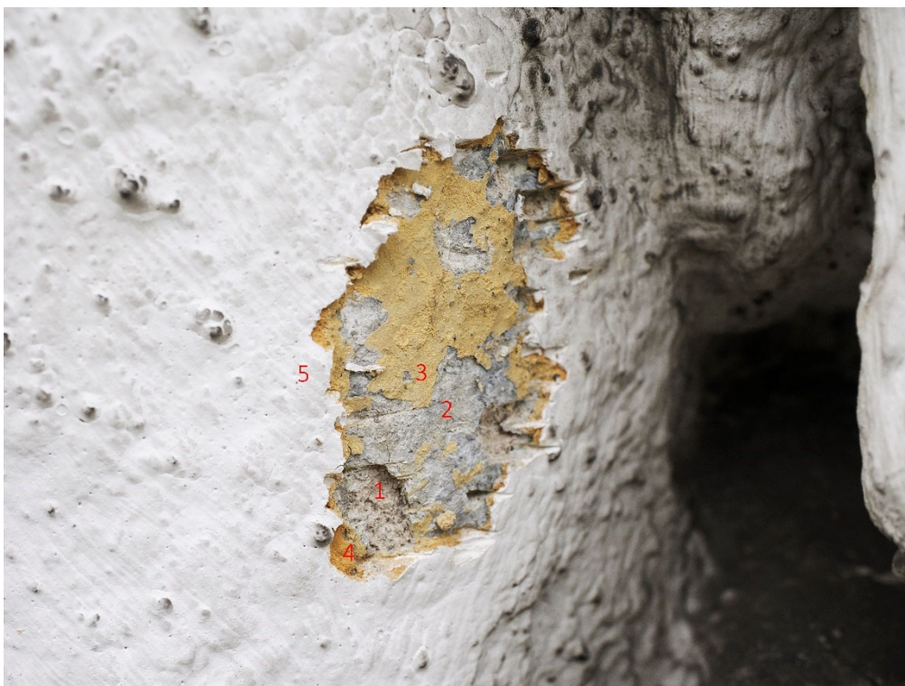
Pohledově pravá tvář. 1- štuk, 2- šedý nátěr, 3-4 – dvě okrové vrstvy, 5 - stávající barevnost
