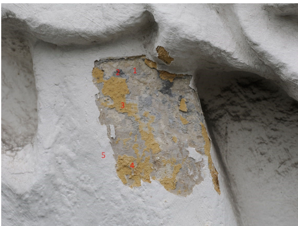
Zdobné prvky niky. 1- štuk, 2- šedý nátěr, 3-4 – dvě okrové vrstvy, 5 - stávající barevnost
