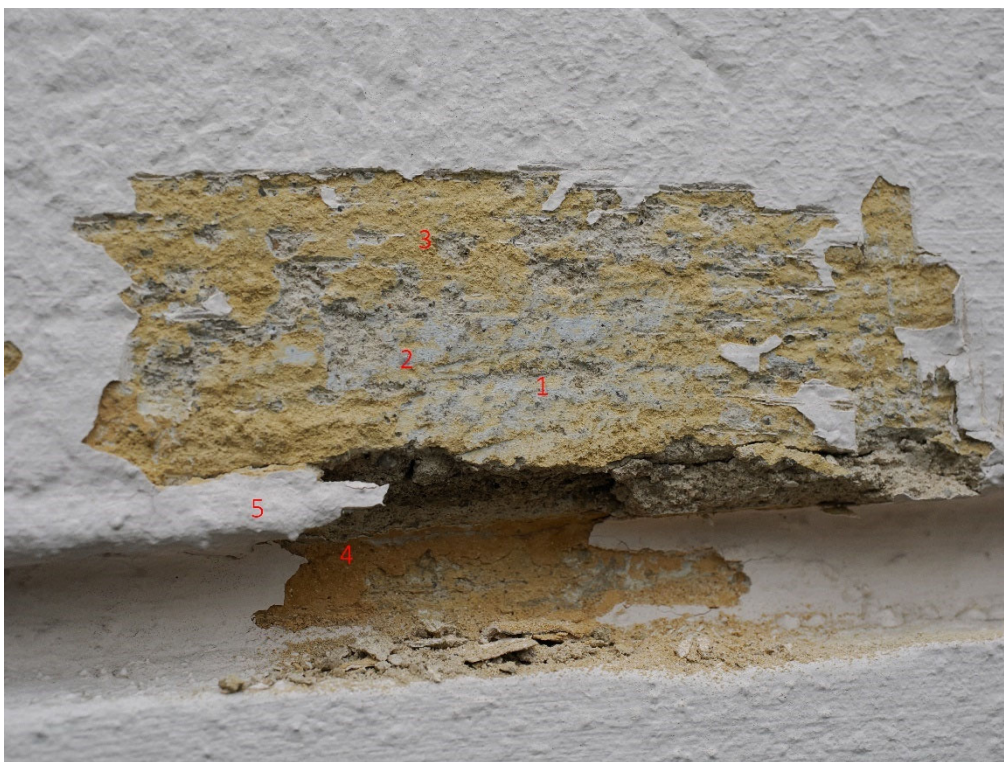
Plocha fasády. 1- štuk, 2- šedý nátěr, 3-4 – dvě okrové vrstvy, 5 - stávající barevnost
