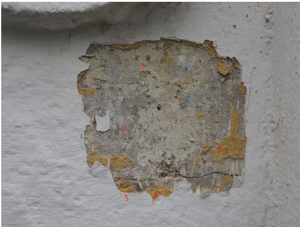
Šambrána niky. 1- štuk, 2- šedý nátěr, 3-4 – dvě okrové vrstvy, 5 - stávající barevnost
