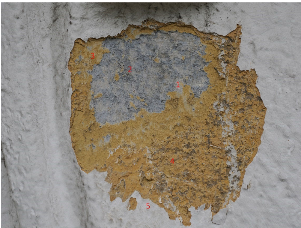
Vlys pod římsou. 1- štuk, 2- šedý nátěr, 3-4 – dvě okrové vrstvy, 5 - stávající barevnost
