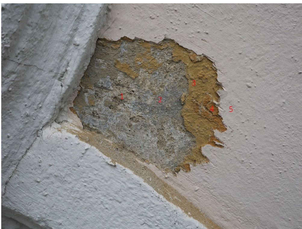
Plocha fasády vedle busty. 1- štuk, 2- šedý nátěr, 3-4 – dvě okrové vrstvy, 5 - stávající barevnost
